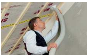
Montage damprem bij inblaas-isolatie
