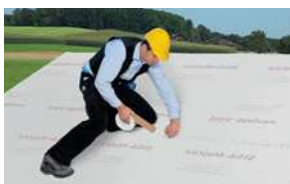
Montage damprem bij dakspantenisolatie
