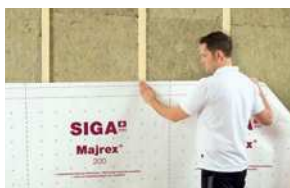
Montage damprem op houtconstructie
