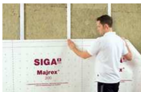
Montage damprem bij binnenmuurisolatie
