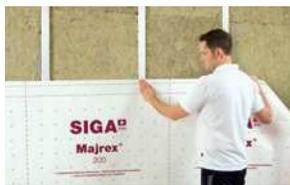
**Pose d'un frein-vapeur en cas d'isolation des murs par l'intérieur**
