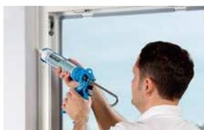
**Le calfeutrement des joints de fenêtres, portes et façades**
