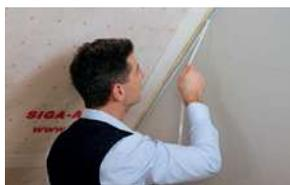
**Frein-vapeur sur mur de construction massive**
