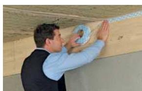
Raccordement d'une panne
