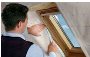
Raccordement d'une fenêtre de toit
