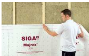
Pose d'un frein-vapeur sur une structure en bois
