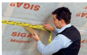
Recouvrements sur un frein-vapeur
