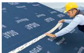
Recouvrement d'un écran de sous-couverture
