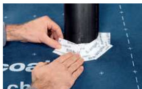
Traversées d'écrans de sous-couverture
