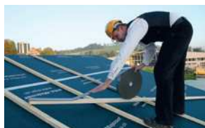
Montage de la bande d'étanchéité pour clous
