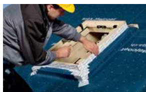
Raccordement d'une fenêtre de toit
