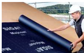
Montage d'un écran de sous-couverture
