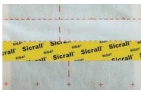
Recouvrements sur un frein-vapeur
