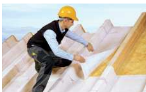
Montage Damprem bij daksanering van buiten
