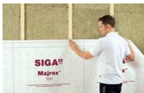
Montage damprem op houtconstructie
