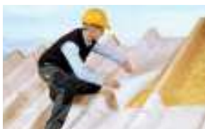
Montage Damprem bij daksanering van buiten
