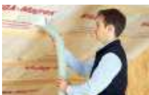
Montage damprem bij inblaas-isolatie
