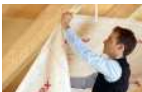
Montage damprem – bij platte en schuine daken
