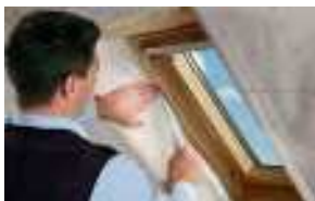
Aansluiting dakraam
