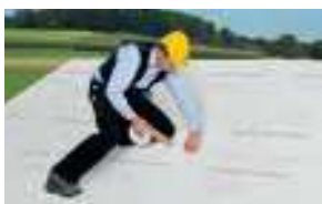
Montage damprem bij dakspantenisolatie
