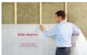
Montage damprem op houtconstructie
